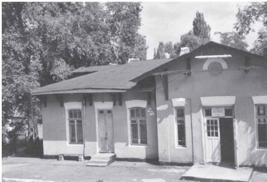
Железнодорожная станция Маймак. Зал ожидания
